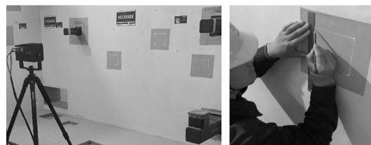
图7 现场支架定位点批量化放样
